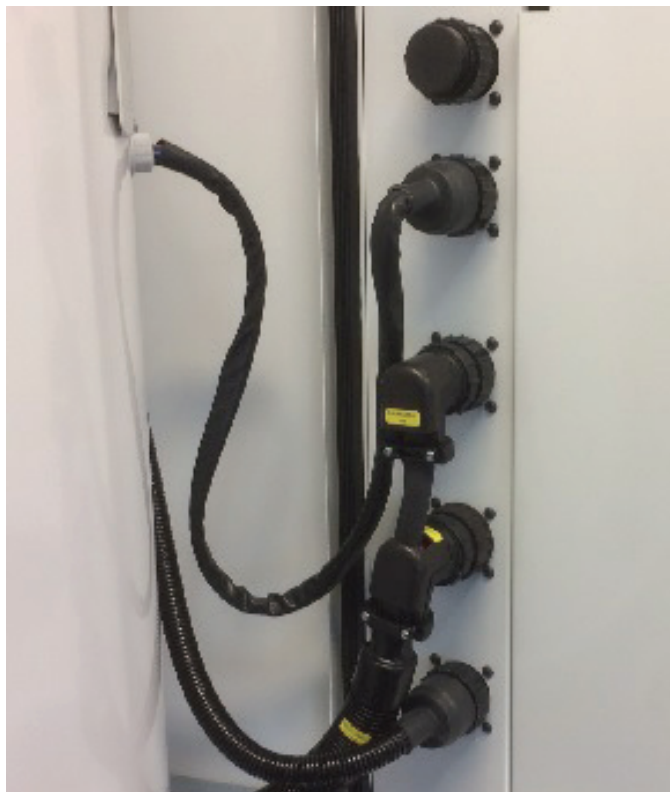
Bilden visar stamkabeln monterad med de tre bajonettkopplingarna.
