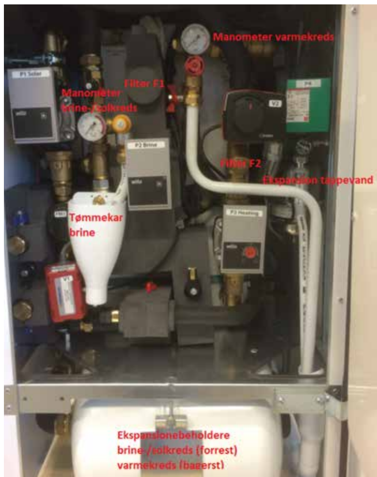
Her vises et billede af HYSS Model R med vigtigste komponenter, som indgår i ovenstående tjekliste.
