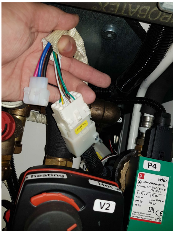
Monter de 3 ledninger i det nye 3-polede stik nye udleverede
