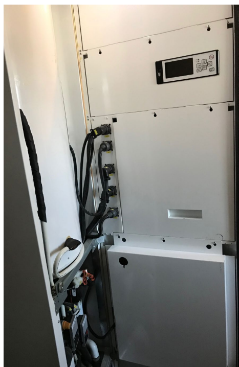
HYSS kabinettets dør med dækplader monteret
