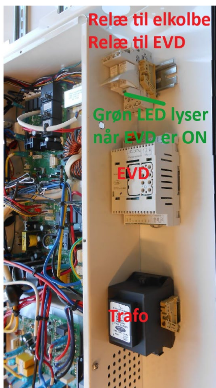
Ved 1 fase sidder der kun 1 relæ til elkolben og 1 relæ til EVD
